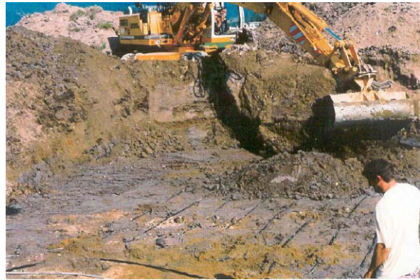
Campo geotermico collettori superficiali
