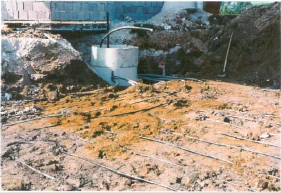
Campo geotermico collettori superficiali
